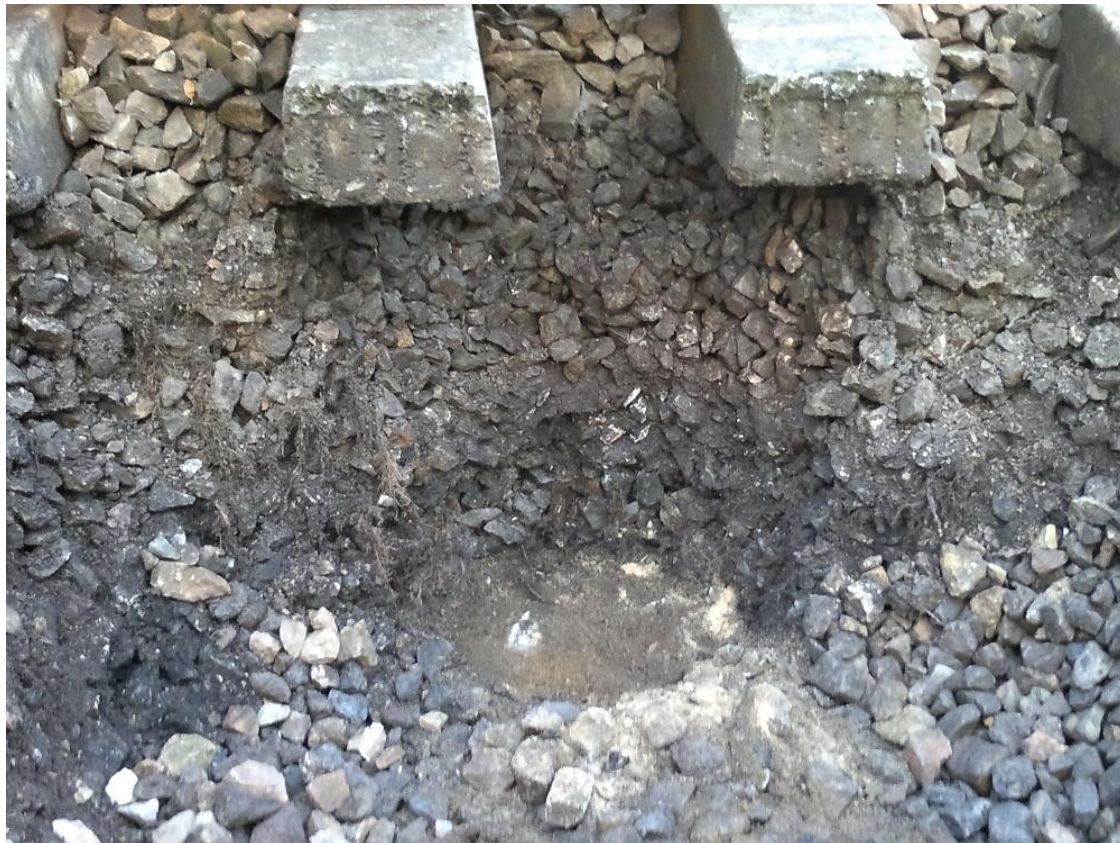
Obr. č. 50 Kopaná sonda KS 60,200 (kolej č. 1)
