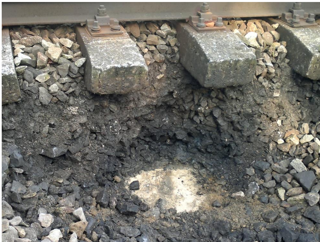
Obr. č. 44 Kopaná sonda KS 58,800 (kolej č. 1)
