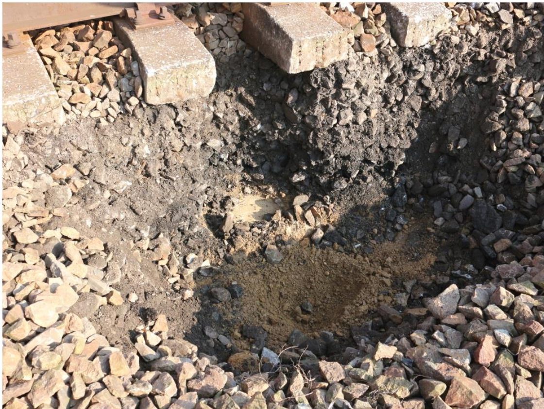
Obr. č. 12 Kopaná sonda KS 53,200 (kolej č. 1)
