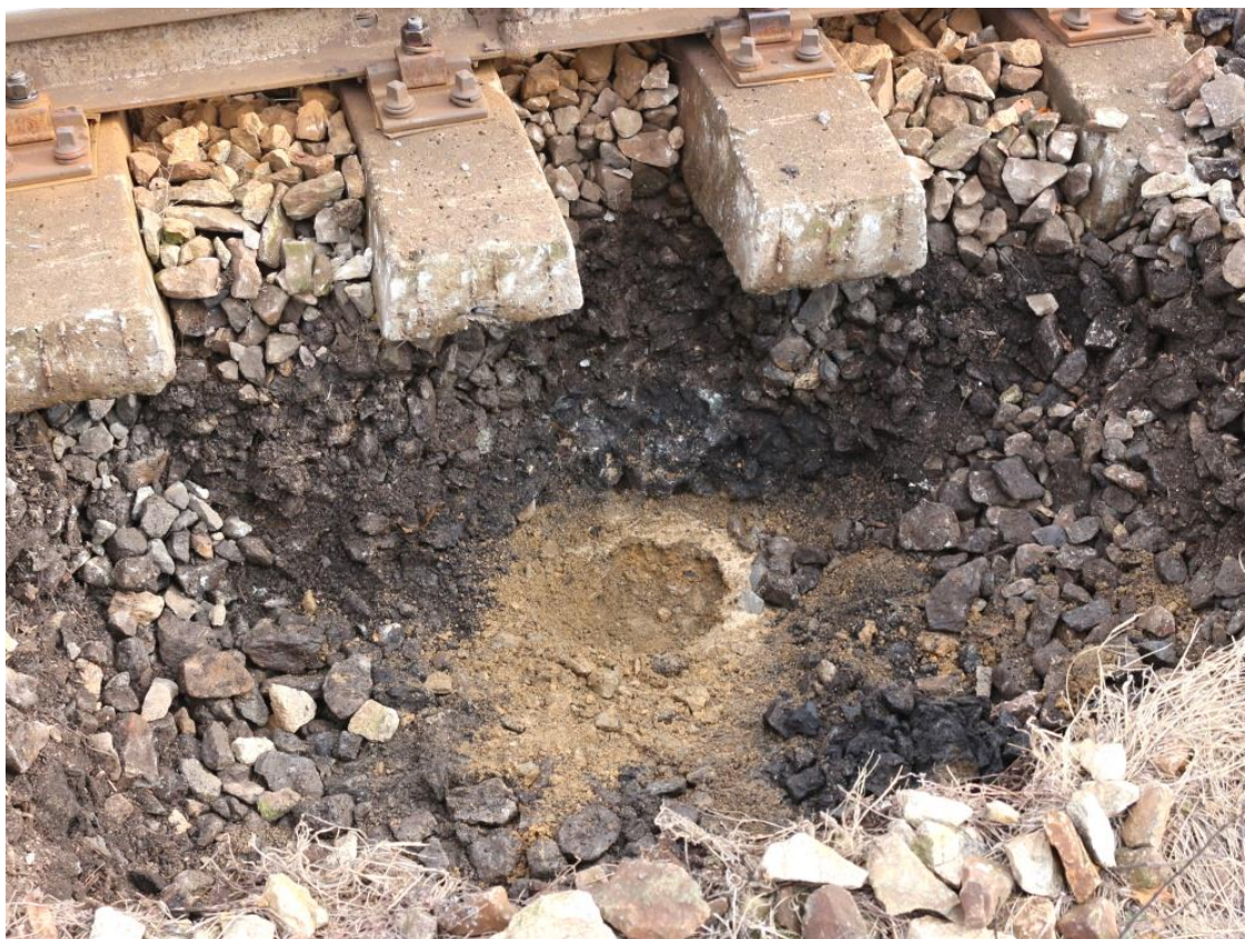
Obr. č. 51 Kopaná sonda KS 60,800 (kolej č. 1)
