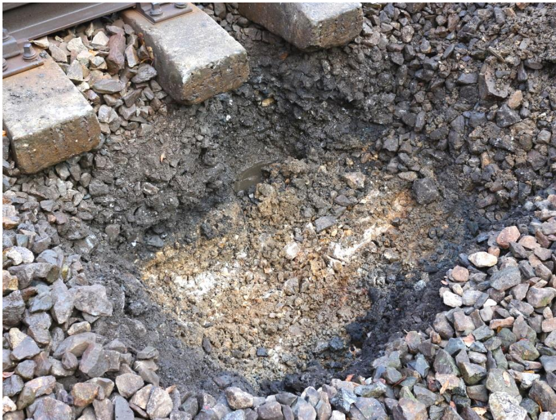
Obr. č. 6 Kopaná sonda KS 51,900 (kolej č. 1) - odkrytí štětové vrstvy
