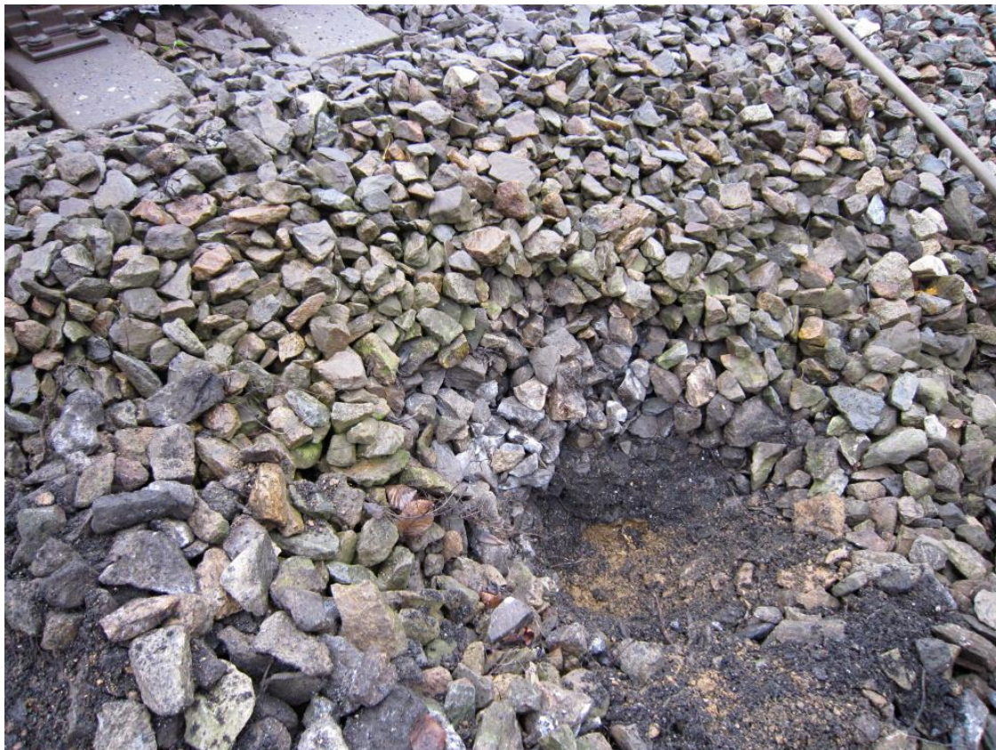
Obr. č. 24 Kopaná sonda KS 55,000 (kolej č. 2) - odběr vzorku k chemické analýze
